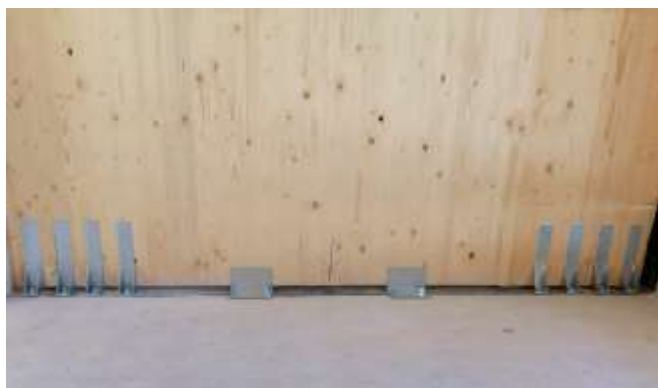
Fig. 3. Rappresentazione schematica ed esempio di parete in CLT connessa in fondazione con Hold-down disposti in serie (foto archivio azienda STP)
