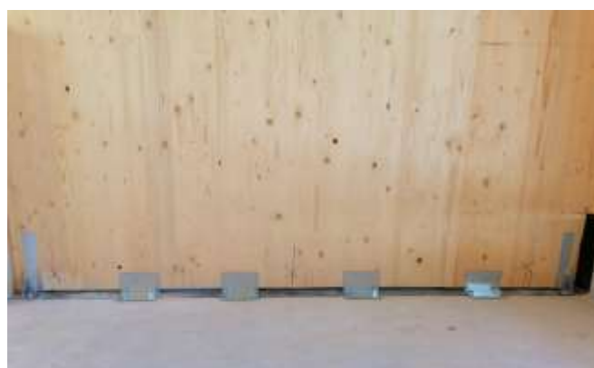
Fig. 1. Rappresentazione schematica connessioni tradizionali ed esempio di parete in CLT connessa in fondazione con Hold-down e angular brackets (foto archivio azienda STP)
