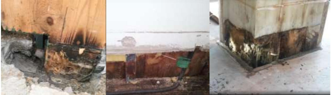
Figura 1: Esempi di fenomeni di degrado riscontrati alla base di edifici esistenti con struttura in legno.
